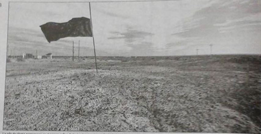
La pila de plomo permanece en el acceso a San Antonio, sin que avancen los trabajos para su remediación.
