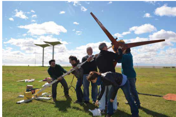
FIG. 17. Curso de 500 RPM probando el funcionamiento del aerogenerador terminado en la costanera de Vicente López, provincia de Buenos Aires
