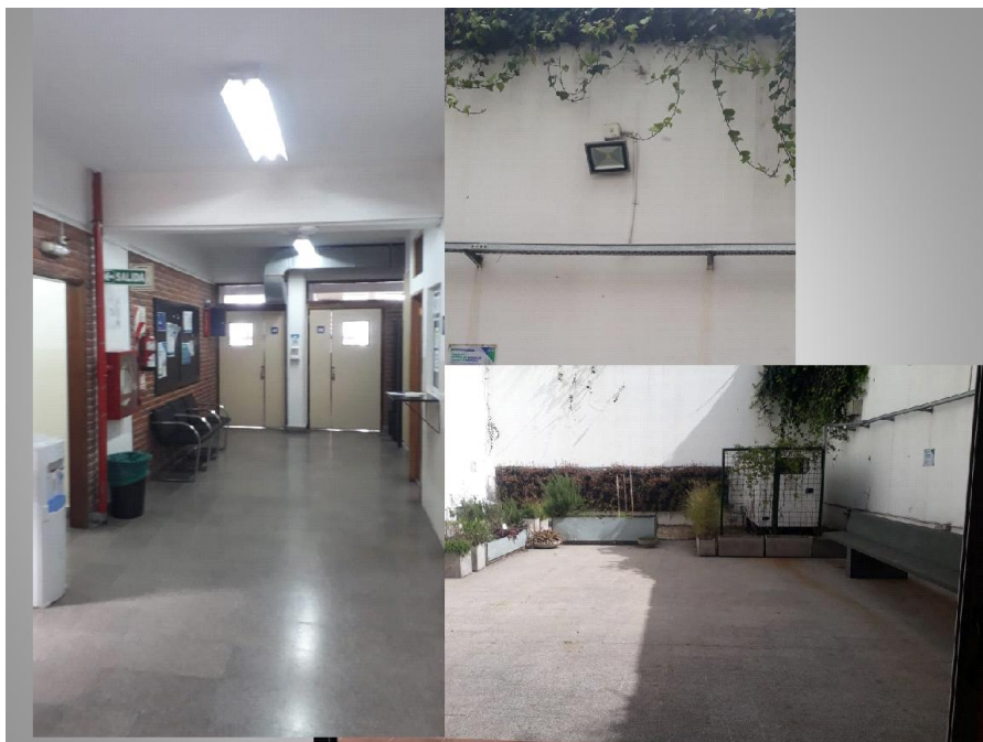
Fotografía 05- Pasillos y Patio PB, iluminación y reflectores.
