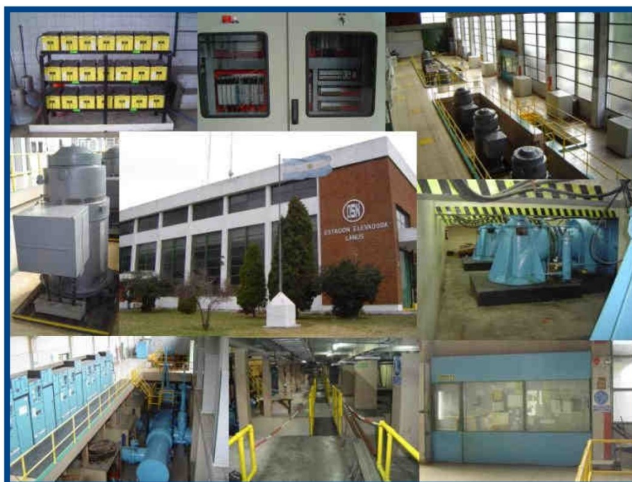
Figura 6. Estación Elevadora Lanús
