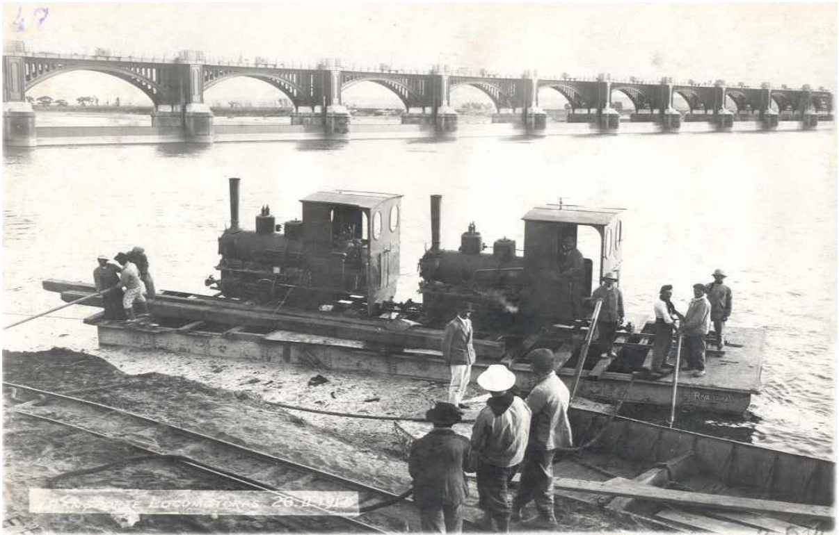
Imagen N° 8 Obreros, balsa que transporta maquina a vapor utilizada en la construcción del Dique Ballester. Fuente Museo Histórico de Riego Barda del Medio.
