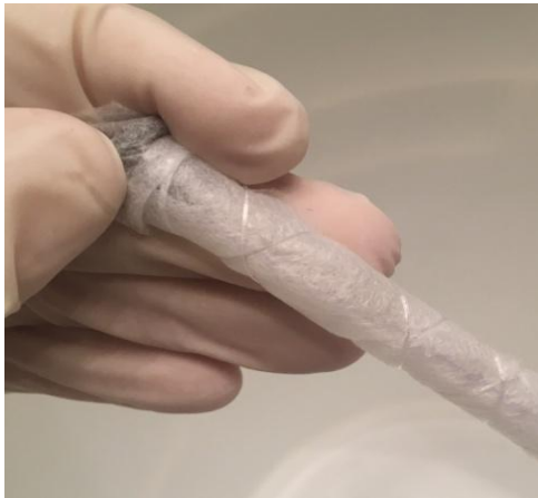
Fig. 18 Manguera tubo envuelta en tela anti-helada y ajustada con tanza.
