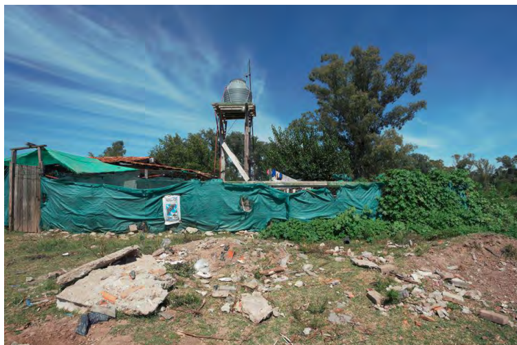
Figura 5: Tanque de reserva domiciliario. Fotografía: Miguel Caamaño.
