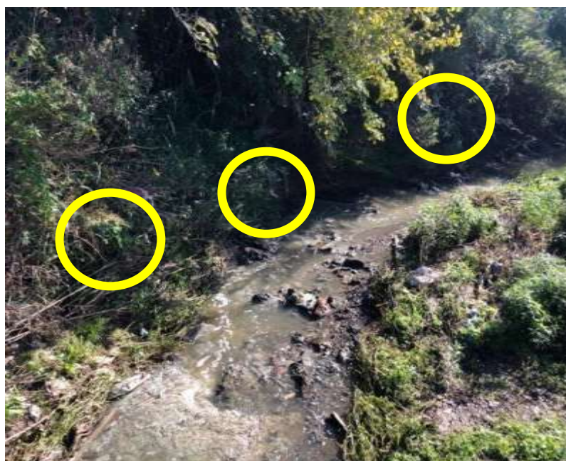
Figura 34. PM1. Se aprecia escasa urbanización, vegetación abundante, botellas y bolsas plásticas retenidas en la vegetación, ante la elevación del nivel de inundación del arroyo (círculos amarillos).
