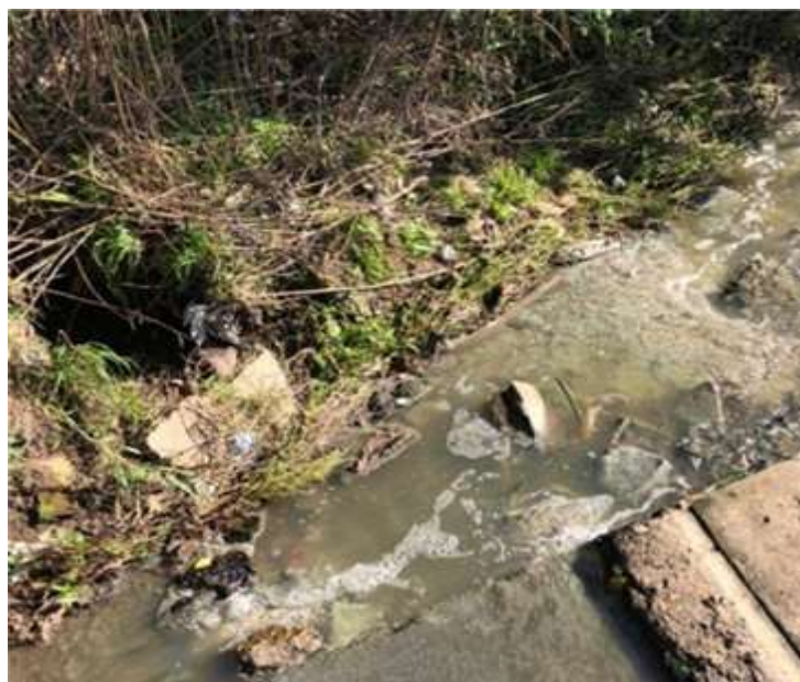
Figura 35. PM1. Se observan residuos urbanos, burbujeo, sobrenadantes y restos de construcción edilicia (caños y partes estructurales de cemento).
