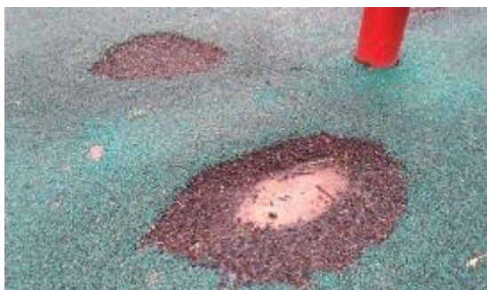
Carpeta de cemento bajo la capa de caucho. Plaza Misericordia.
