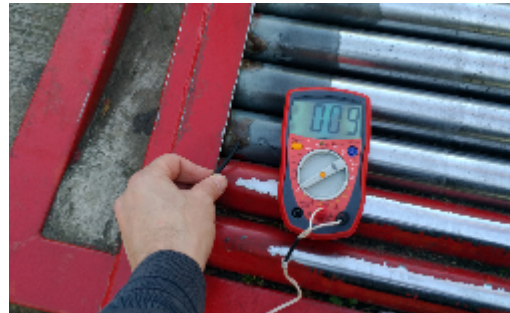
Sobre el mismo equipamiento se observan 9 °C en invierno
