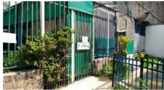
Vista del acceso lateral.
